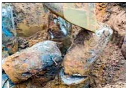
B Quebra controlada da estaca
